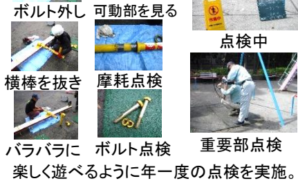
ボルト外し 可動部を見る 横棒を抜き 摩耗点検 バラバラに ボルト点検 重要部点検 楽しく遊べるように年一度の点検を実施。
